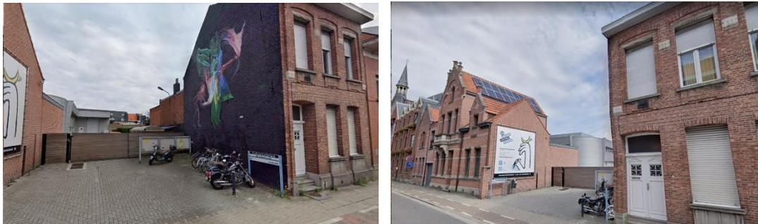
Figuur 16 Deelzone 4: Links – zicht op woning nr. 11 in 2022, rechts – zicht op woning huisnr. 11 en gebouwen gemeentebestuur in 2022 (bron: Google Maps).
